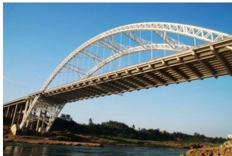
图 2 来华大桥照片
