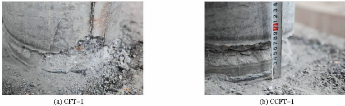
图 4 核心混凝土破坏
